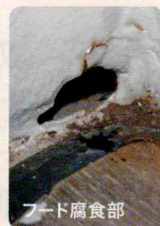
船尾フード(手動操舵装置周辺)
